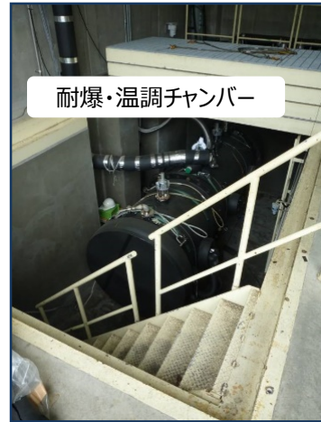
地下ピット（試験時）
